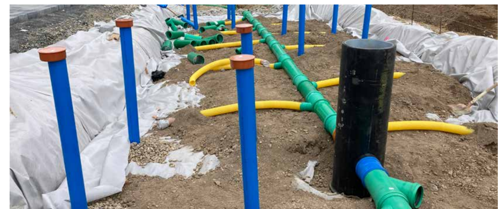
Einbau der Baumrigole im Hochbeet
